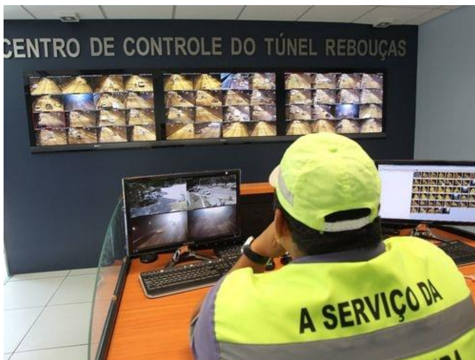
Figura 2.16: Centro de controle do Túnel Rebouças
