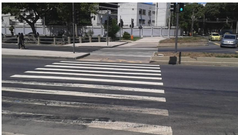
Imagem 7.12: Falta de adaptação para aguardar o fechamento do sinal entre as pistas – Av. Maracanã.
