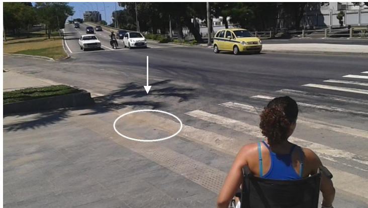
Figura 7.14: Desnível entre o leito carroçável e o final da rampa – Av. Maracanã
