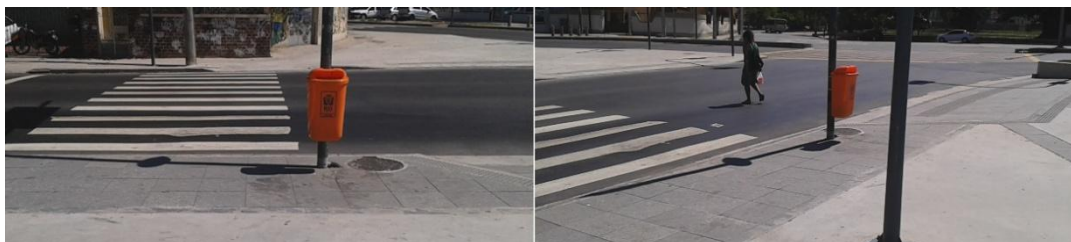
Figura 7.16: Desalinhamento entre guias rebaixadas e travessias – Rua Prof. Eurico Rabelo
