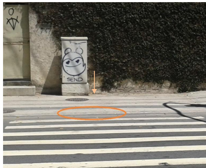
Imagem 7.15: Desnível entre o leito carroçável e o final da rampa e pequena largura da calçada – Rua Prof. Eurico Rabelo
