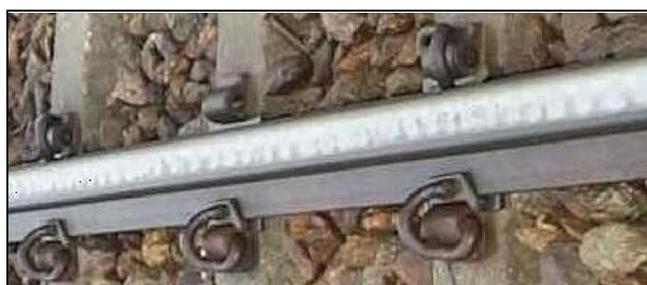
Figura 3.10: Ondulação em trilho verificada no trecho estudado por Gullers *et al.* (2008).
