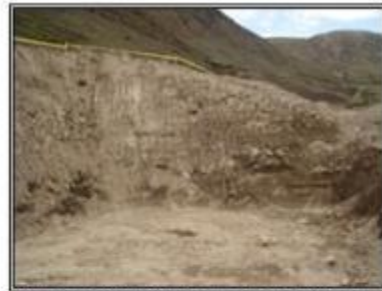
Foto 1. Suelo derecho, superficialmente, esta cubierta de arena gruesa y grava pequeña.
