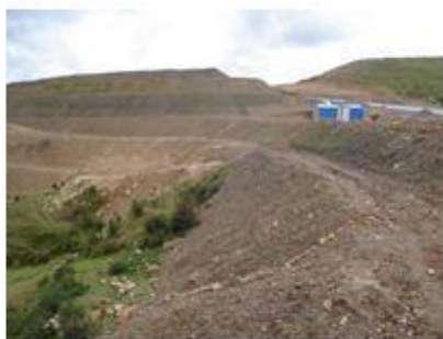
Foto 1: Vista del pie de Botadero 11
