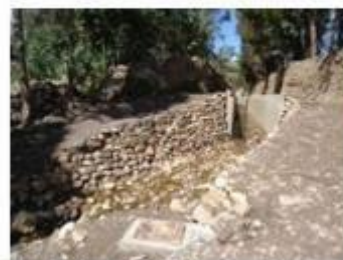
Foto 3: Marco km 42+481 – Desagüe
