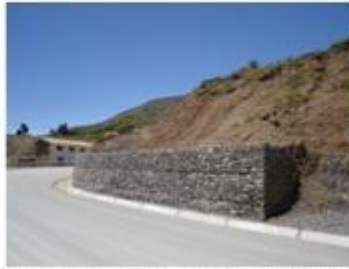
Foto 1: Vista del inicio del Muro en Gavión – km 46+830 al 46+940
