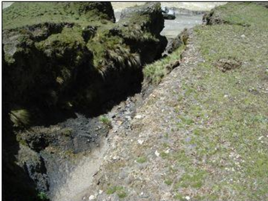
Foto 3 - Cárcava formada por el curso natural de la quebrada, donde la construcción de la carretera considera taludes de corte. Abajo se ubica el eje de la alcantarilla.
