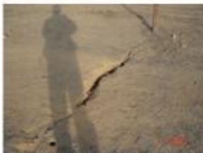
Foto 4: Agrietamientos en la banqueta superior del botadero.
