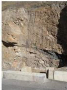
Foto 53: Alcantarilla km 47+987 – A. Arriba
