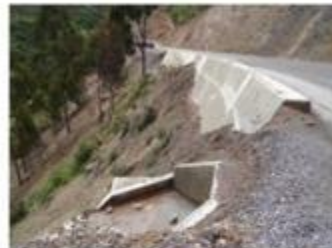
Foto 5: Vista del inicio del Muro en Concreto Ciclópeo – km 51+430 al 51+490
