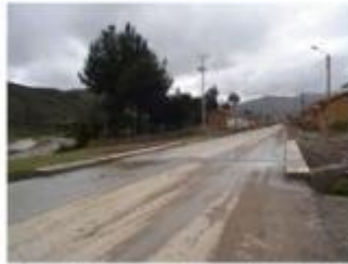
Foto 1: Vista superior del Pontón km 42+188
