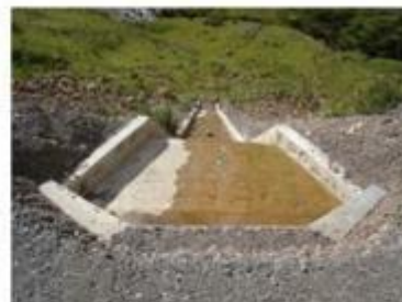
Foto 54: Alcantarilla km 47+987 – A. Abajo
