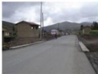
Foto 4: Vista superior del Pontón km 43+479
