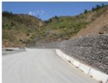
Foto 2: Vista del final del Muro en Gavión – km 46+830 al 46+940
