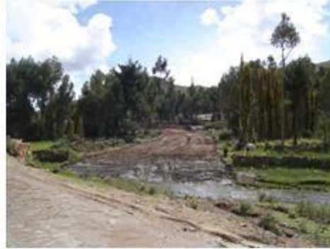
Foto 01: Km 35+850 – Hacer una travesía de tubería para abastecimiento de agua.
