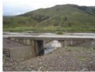
Foto 2: Aguas arriba del Pontón km 42+188
