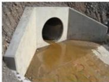
Foto 55: Alcantarilla km 47+987 – A. Abajo
