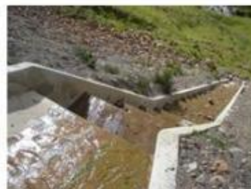
Foto 56: Alcantarilla km 47+987 – Desagüe
