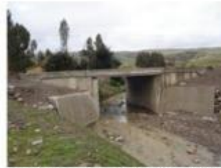
Foto 3: Aguas abajo del Pontón km 42+188
