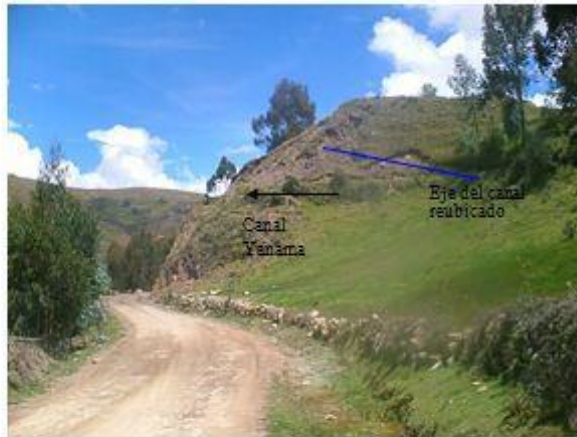
Foto 1. Km. 77+780. Vista panorámica (hacia atrás) del canal Yanama en el sector a reubicar.
