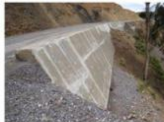
Foto 6: Vista del final del Muro en Concreto Ciclópeo – km 51+430 al 51+490
