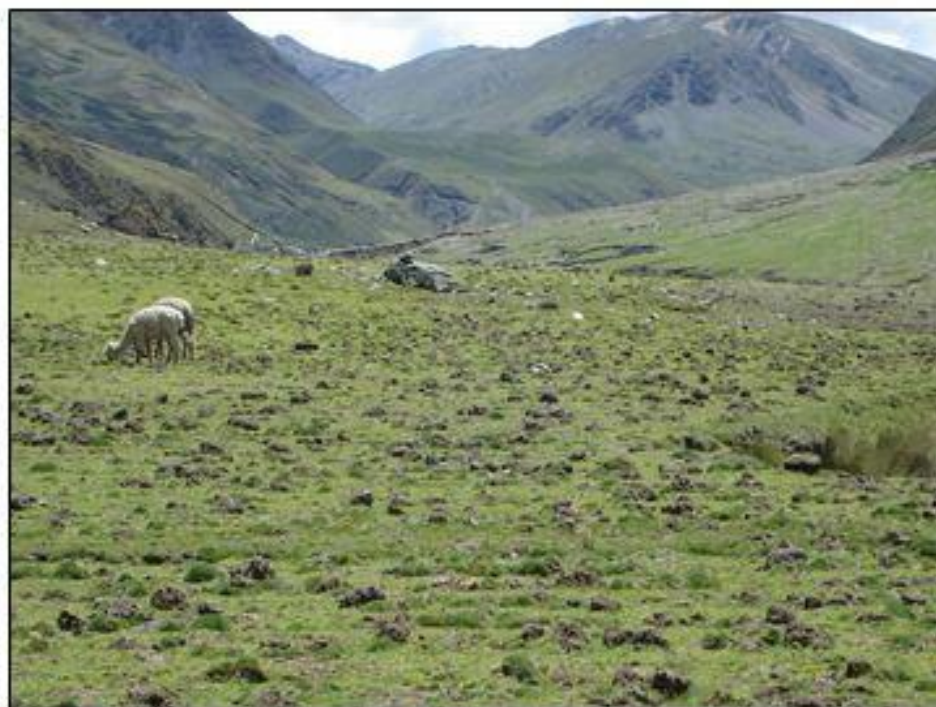
Foto 4 - Área donde se construirá los canales trapezoidales de intercepción de flujo de la quebrada.
