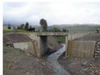
Foto 6: Aguas abajo del Pontón km 43+479
