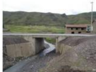
Foto 5: Aguas arriba del Pontón km 43+479
