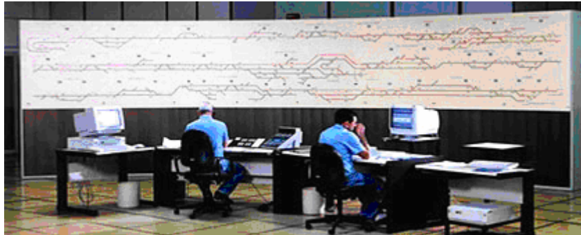
Figura 15 – Centro de Controle Operacional Fonte: MRS (2008)
