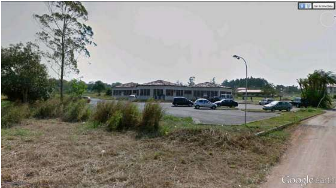
Figura 18: Estacionamento no anexo da pós graduação do ICHS Fonte: Streetview – Google earth
