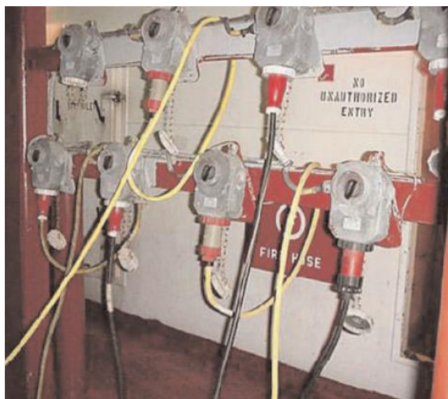
Figura 5 – Conectores para alimentação elétrica dos reefers no navio Fonte: UK P&I CLUB (2012)
