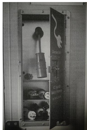
Figura 7 - Conectores para alimentação elétrica do envirotainer na aeronave
