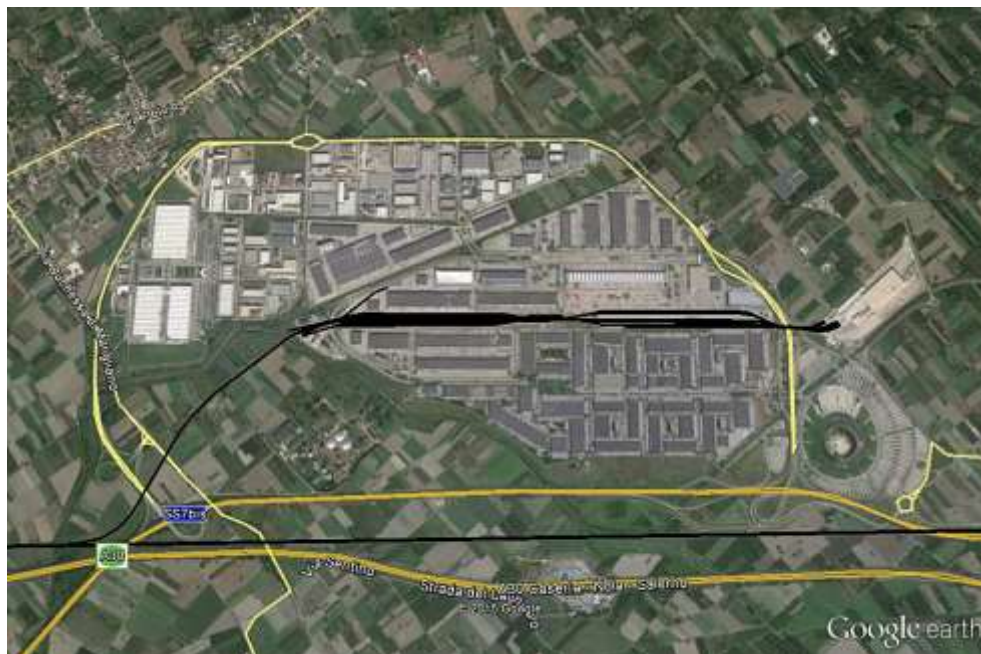
Figura 2.11 – Plataforma Logística Multimodal de Nola
