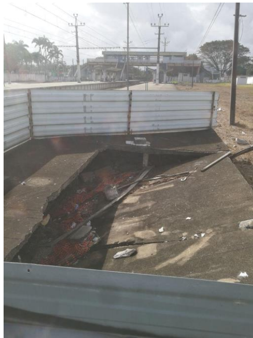
Figura 30: Plataforma da Estação Benjamin do Monte
