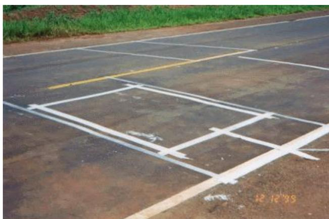
**Figura 2.4** : Laço (*loop*) magnético – foto obtida de DNIT(n/a)
