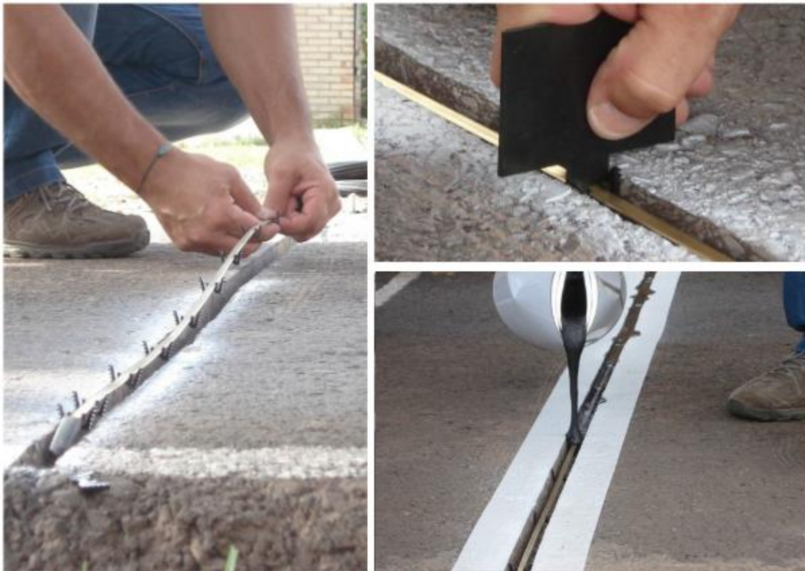
Figura 2.10: Instalação de sensores Piezoelétricos. Fonte: Brito et al. (2014)
